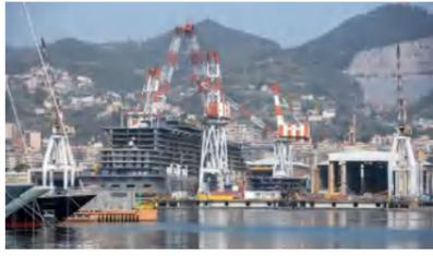
Sestri Ponente. Nelle aree del ribaltamento a mare di Fincantieri i lavori procedono a ritmo sostenuto e a gennaio 2026 è prevista la consegna della *banchina di allestimento*. Ogni operazione richiede precisione assoluta perché tutto viene realizzato in acqua. Sono già state effettuate operazioni di collaudo e due prove di carico sui pali
